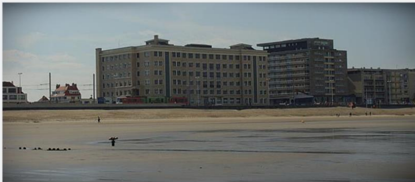
Revalidatieziekenhuis IMBO en WZC Het verhaal Zeedijk 286 - Oostende
